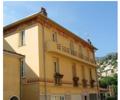
▲ Figure 9 : rénovation d'un bâtiment avec un enduit chanvre extérieur et finition badigeon de chaux, BCB Tradical
